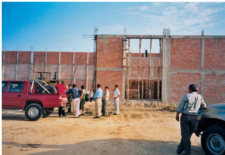
Cepicafé: planta de procesamiento en construcción
